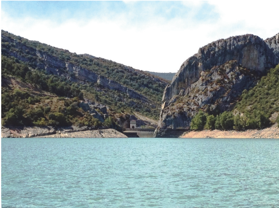
Figura 7. Vista de la presa del embalse
