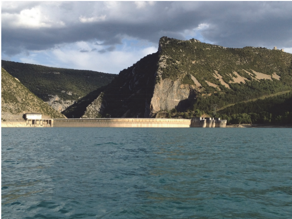
Figura 7. Vista de la presa del embalse
