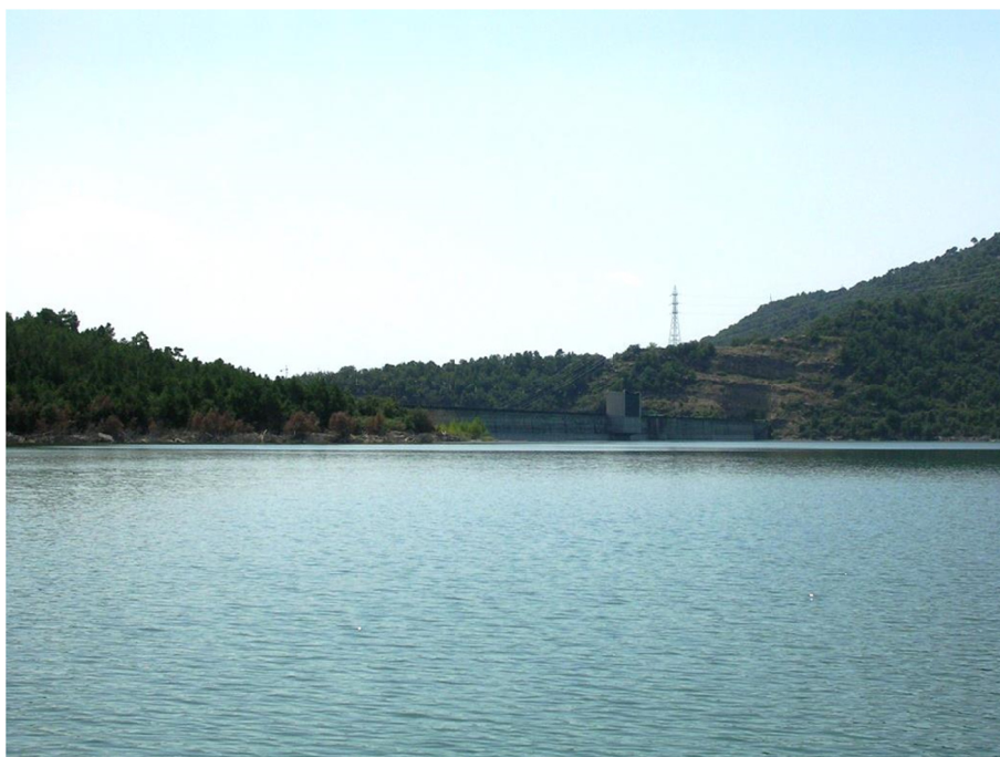
Figura 7. Vista de la presa del embalse
