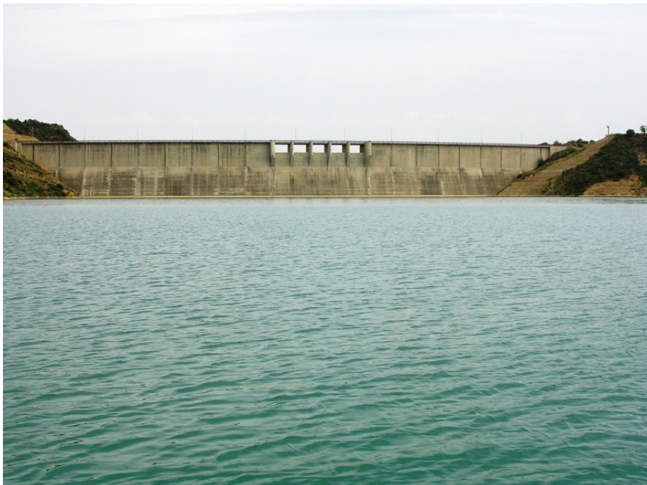
Figura 7. Vista de la presa del embalse.
