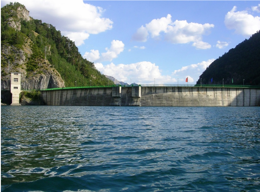
Figura 7. Vista de la presa del embalse
