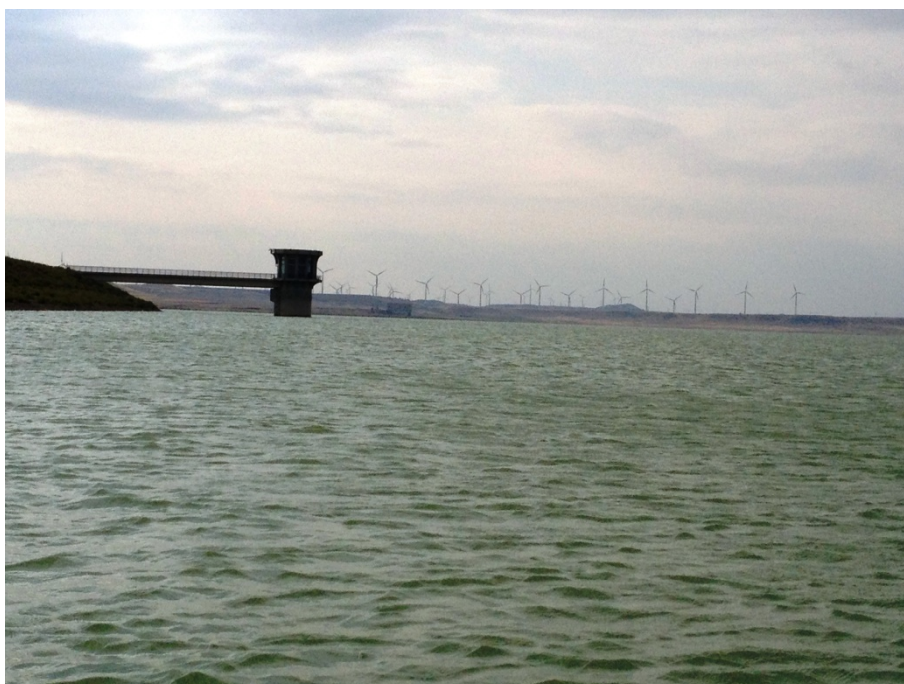
Figura 7. Vista de la presa del embalse
