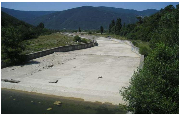
Cauce canalizado con fondo del lecho totalmente hormigonado. Río Sía, afluente del Gállego, en Biescas. Foto: Alfredo Ollero.
