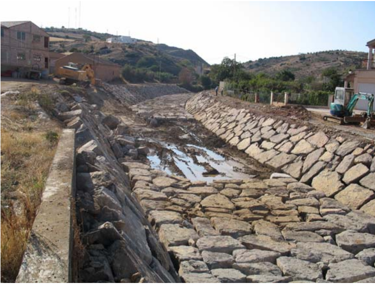
Canalización del río Herrera en Herrera de los Navarros. Foto: Daniel Ballarín.
