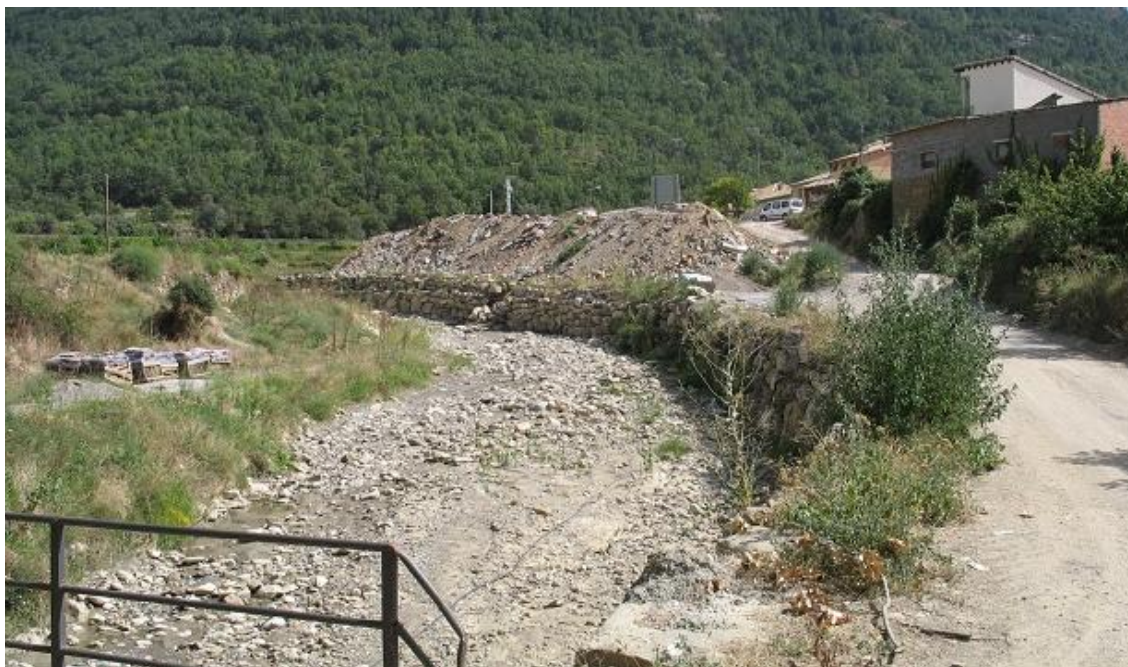
Figura 0-4. Canalización de un pequeño barranco lateral del río Ésera en Santa Liestra.
