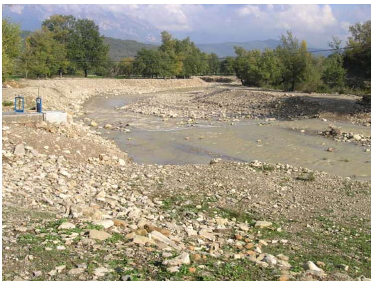
Fondo del lecho del río Sieste (cuenca del Cinca) destruido por un dragado, actuación “de urgencia” tras la crecida de julio de 2001. Foto: Alfredo Ollero.
