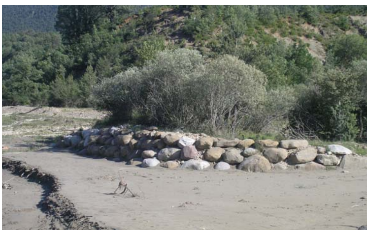
Escollera construida con bloques extraídos del propio cauce en el río Basa, afluente del Gállego, rodeando unos sauces naturales. Foto: Alfredo Ollero.
