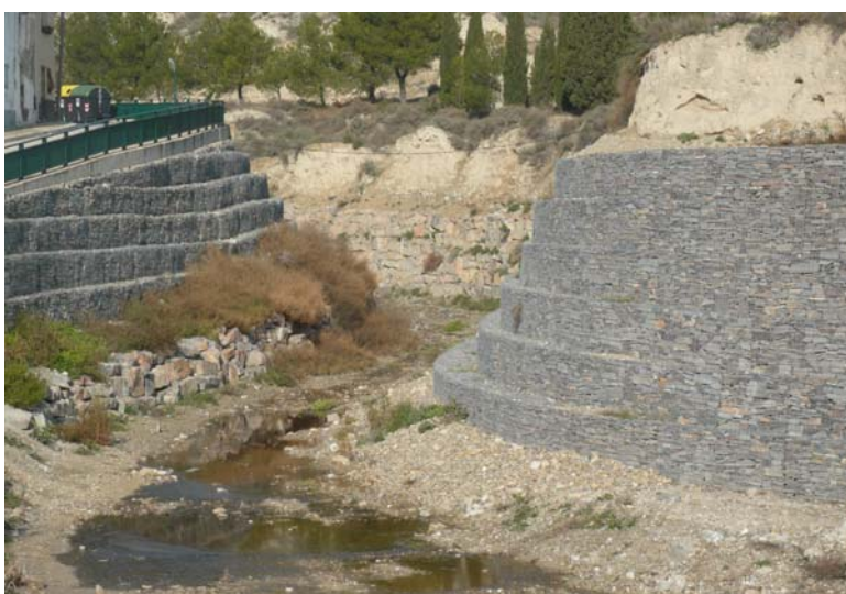
Encauzamiento con escollera y gaviones del barranco de los Lecheros en Alfocea (Zaragoza). Foto: Alfredo Ollero.
