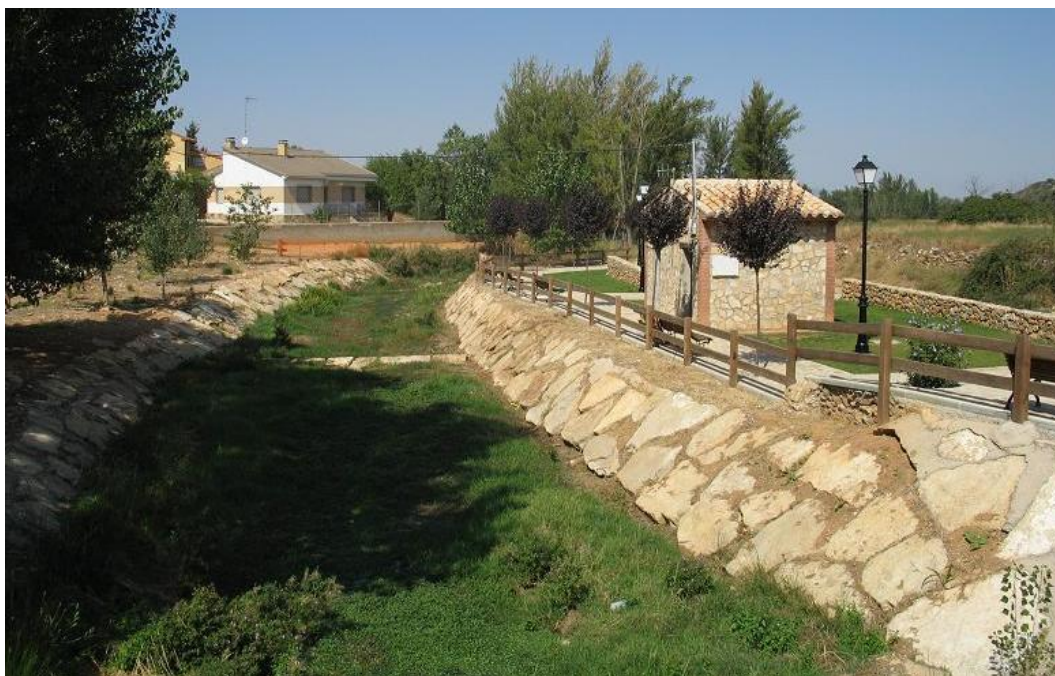
Figura 0-8. Canalización en tramos medios del río Huerva.
