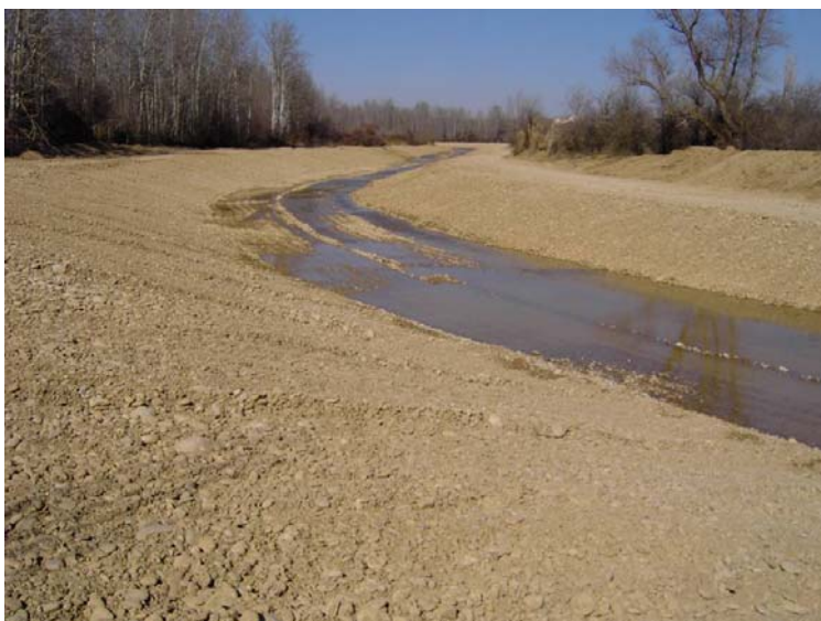
Resultado de dragados en el río Arba de Luesia en Rivas. Foto: Alfredo Ollero.
