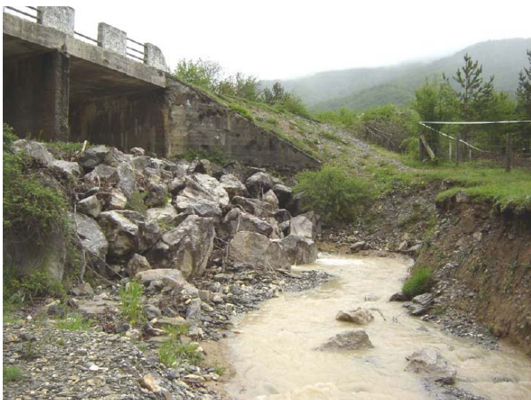
Refuerzo del puente aguas abajo a causa de la incisión registrada. Foto: Juan Pedro Martín Vide
