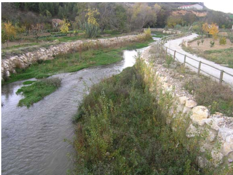
Orillas totalmente desnaturalizadas, e impedida su dinámica lateral, por canalización con escollera. Río Huerva en Tosos. Foto: Alfredo Ollero.
