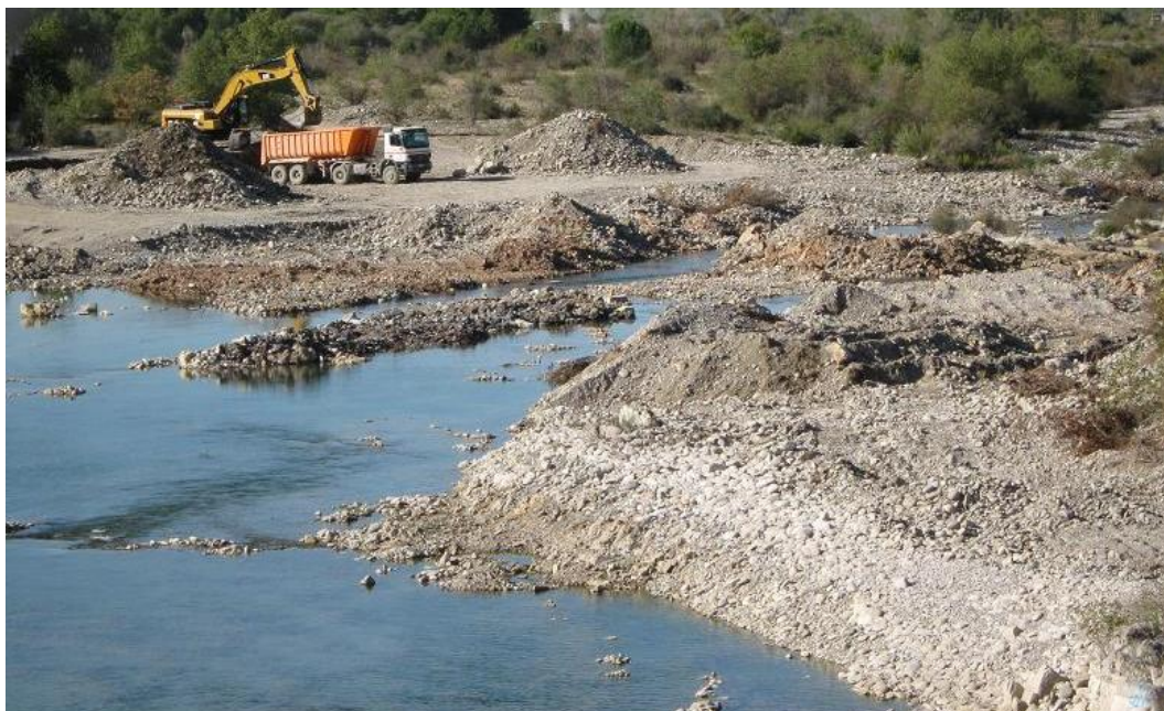
Figura 0-7. Dragado del río Cinca en el Puente las Pilas.
