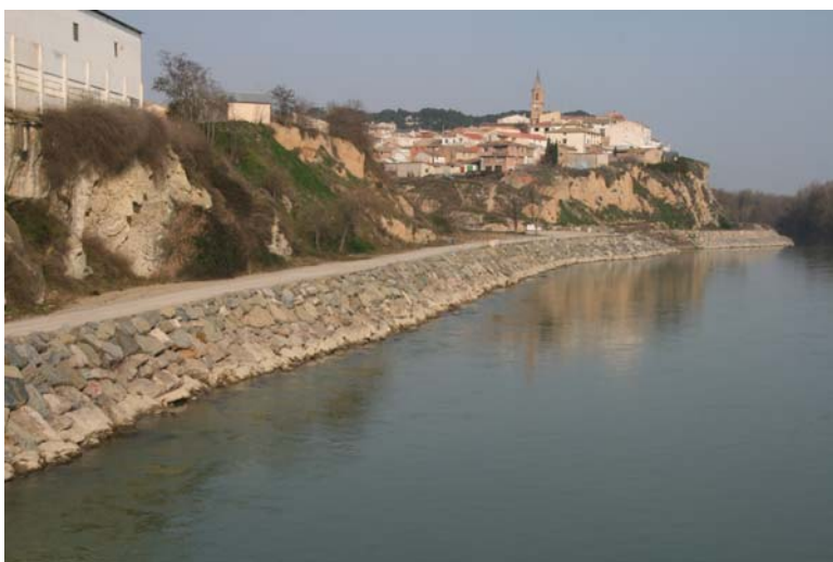
Escollera en la margen derecha del río Aragón en Milagro (Navarra). Foto: Alfredo Ollero.
