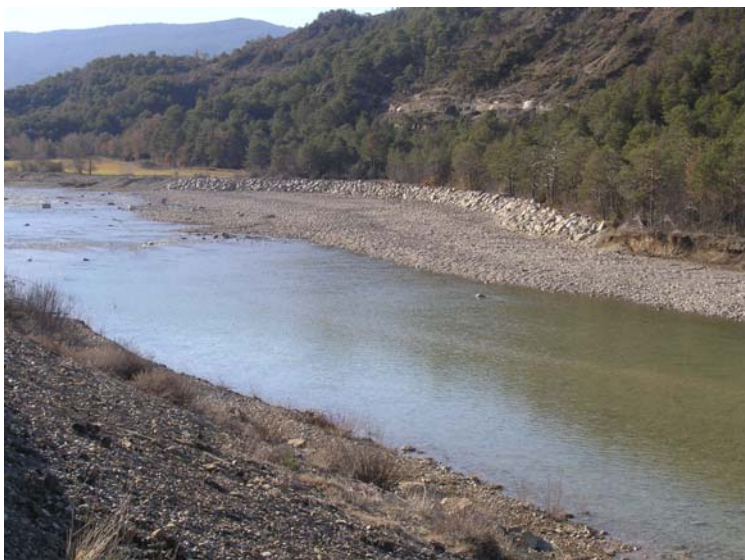
Otra escollera que aparentemente no protege ningún bien, acompañada de dragado del cauce en el río Guarga cerca de Arraso. Foto: Alfredo Ollero.
