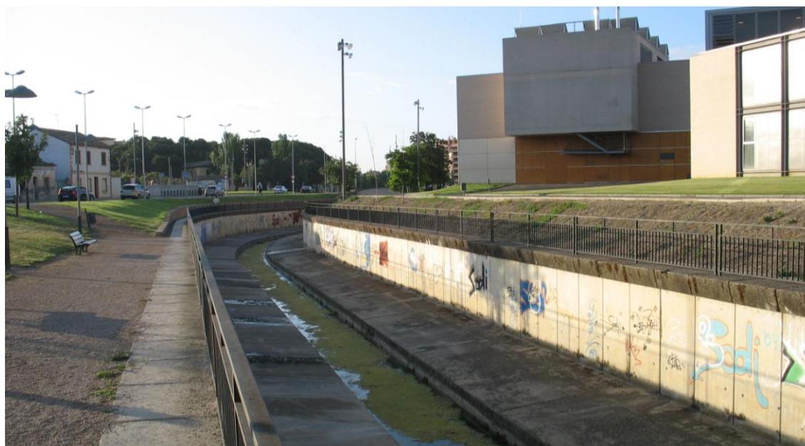
Figura 0-5. Canalización del río Isuela a su paso por Huesca.
