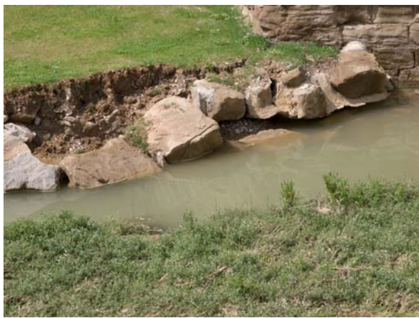
Respuesta del río Sosa a la canalización, incidiendo en el lecho y desmoronando el escollerao. Fotos: José María Puig.
