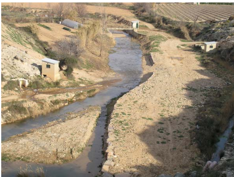
Modificación de la margen derecha del cauce entre la presa de Mezalocha y la estación de aforo. Foto: Alfredo Ollero
