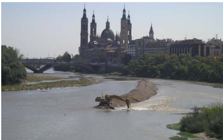
Dragado del río Ebro en Zaragoza en el verano de 2007. Foto: Alfredo Ollero.
