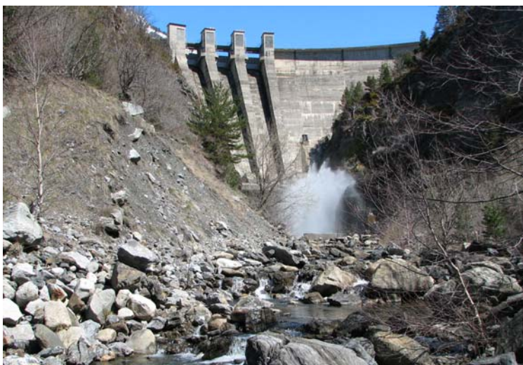
Desnaturalización hidrológica y acorazamiento de bloques al pie del embalse de Paso Nuevo en el río Ésera. Foto: Daniel Mora.
