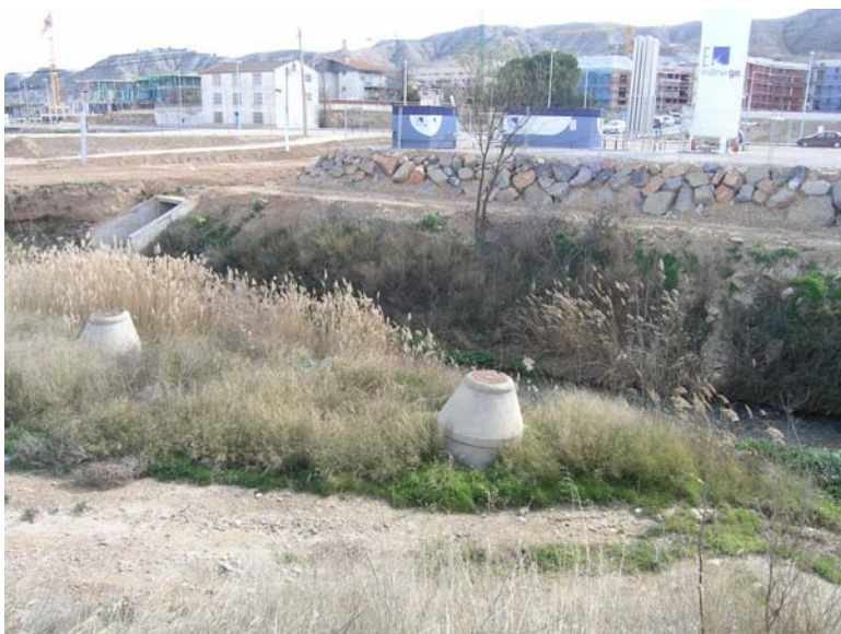
Canalización asociada al proceso de urbanización en Cadrete. Foto: Alfredo Ollero.
