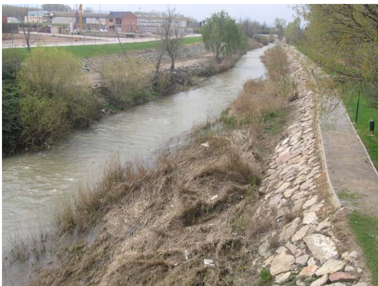
Ribera muy deteriorada en otro proceso de urbanización fluvial, el río Alhama en Alfaro. Foto: Alfredo Ollero.
