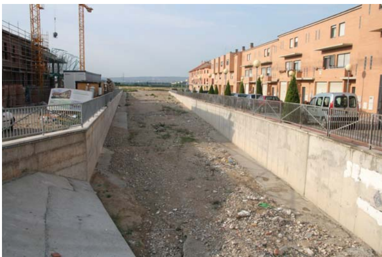
En urbanizaciones recientes se han ejecutado canalizaciones con artificialización total de las márgenes. Barranco de la Puebla de Alfindén. Foto: Alfredo Ollero.
