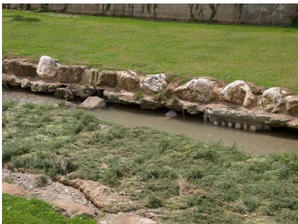
Respuesta del río Sosa a la canalización, incidiendo en el lecho y desmoronando el escollerao. Fotos: José María Puig.
