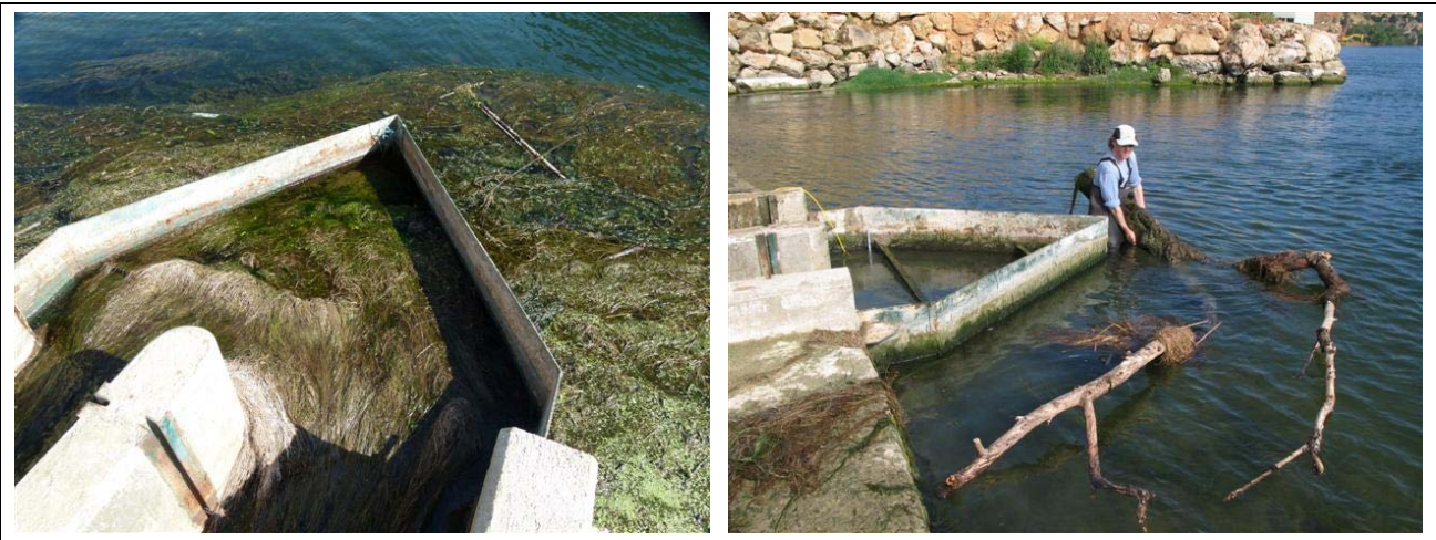
Fig. 10. Restos vegetales acumulados en la parte superior de la escala.
