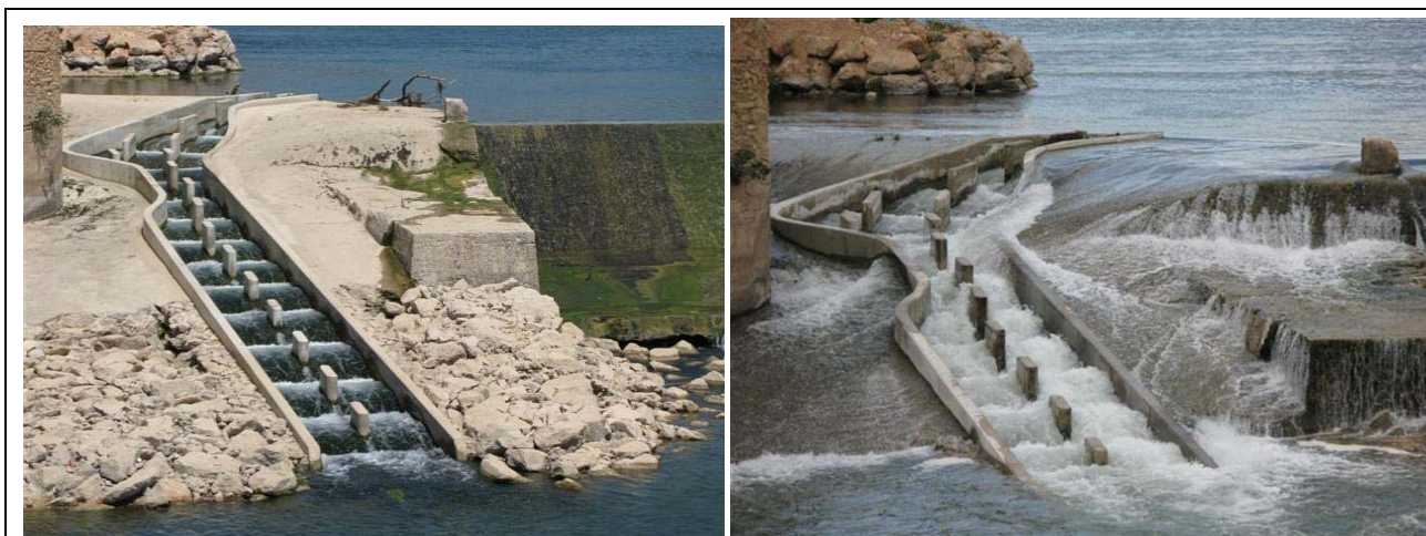
Fig. 11. Estado de la escala durante los períodos de caudal base (izquierda) y durante las crecidas (derecha) del río Ebro.
