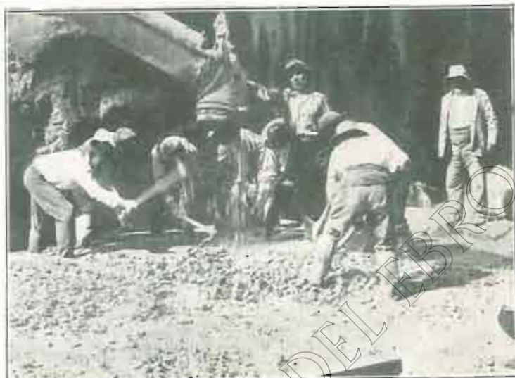
Vertido de hormigón en el cuenco de cimiento de la presa.
