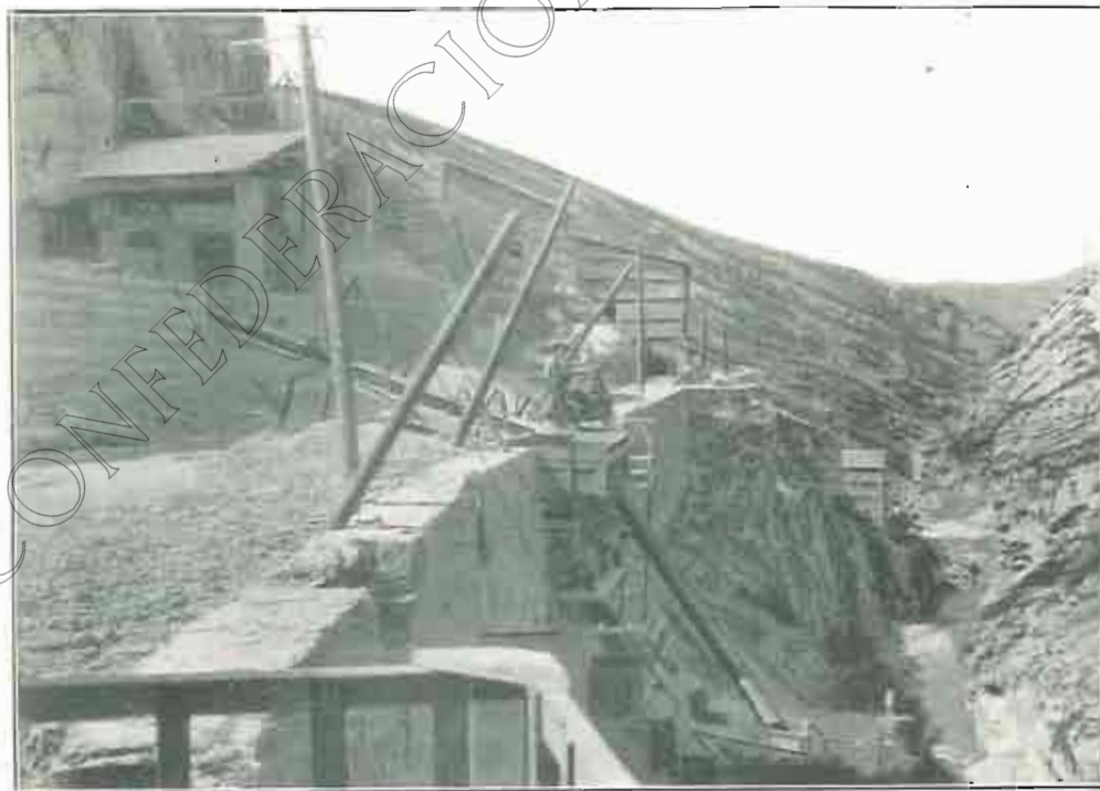
Relleno de hormigón en el cuenco de cimiento.
