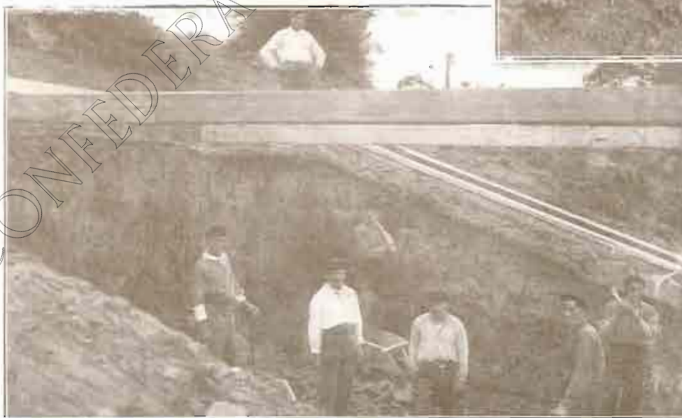
Pozo de acceso a la futura cámara de compuertas, por cuya excavación se ha dado comienzo a las obras hidráulicas
