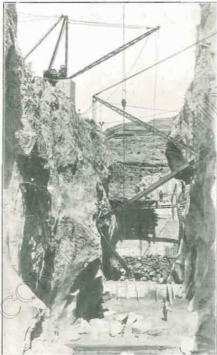
Vista general del cuenco de cimiento. — En primer término, un escalón ya terminado. En segundo, hormigonando otro escalón. Al fondo, la ataguía de agua arriba. (1 de septiembre de 1928).
