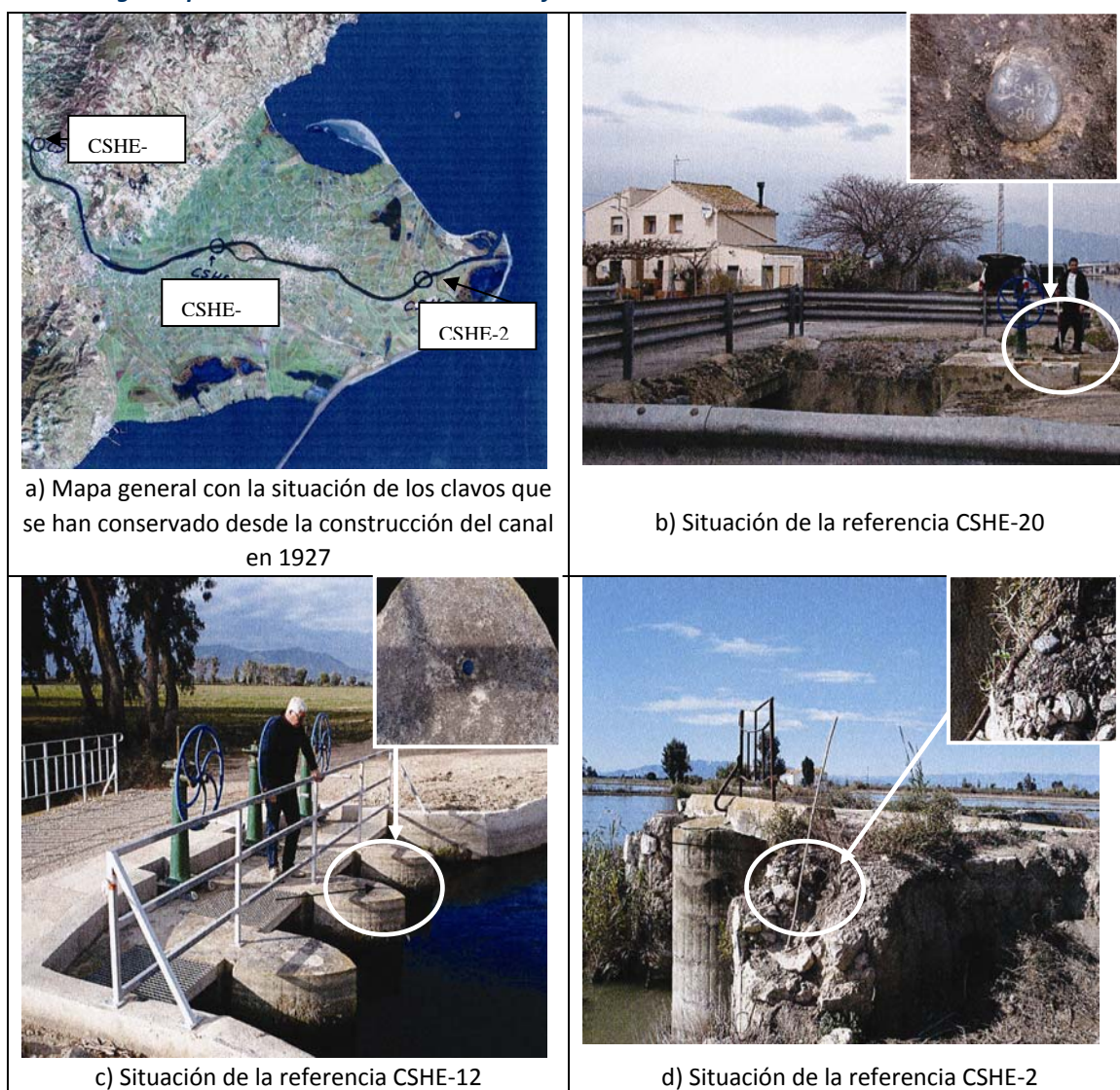
Figura 11: Situación de las referencias topográficas instaladas en 1927 durante la construcción del canal de la margen izquierda del delta del Ebro e identificación en el año 2012.
