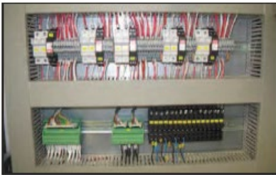
Detalle Distribución de 24VCC y Salidas Analógicas.
