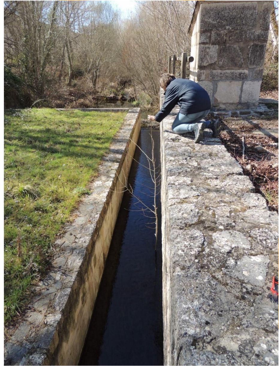
Estación de aforos ACA 41 (Río Ciurana aguas debajo de la derivación del Tránsito a Ruidecañas (21/2/2018))
